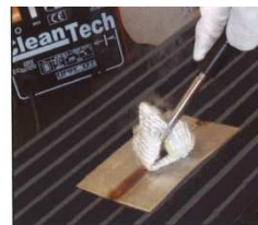
Reinigen der Schweißnaht
